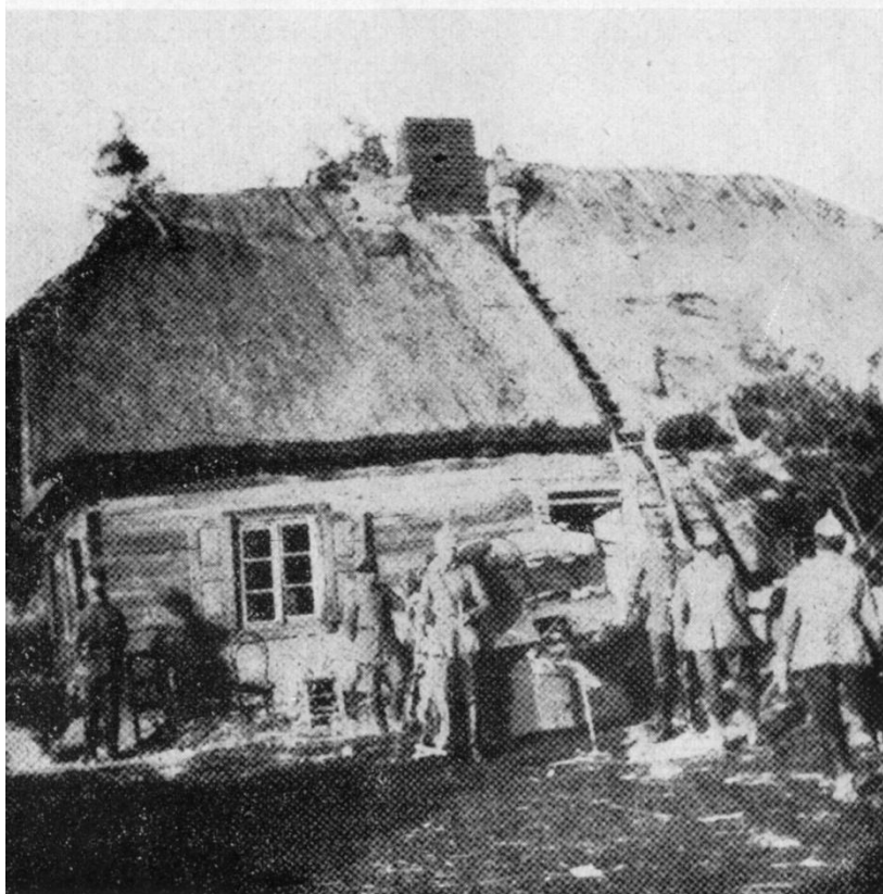
Observationspost på et hus.
