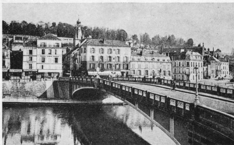
Chaieau-Thierry med bro over Marne
