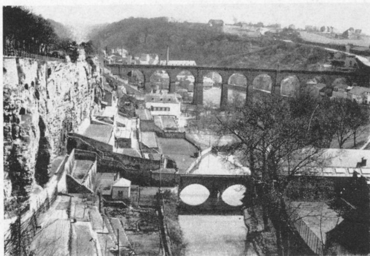
Luxemborg by - Til venstre fæstningsmuren
